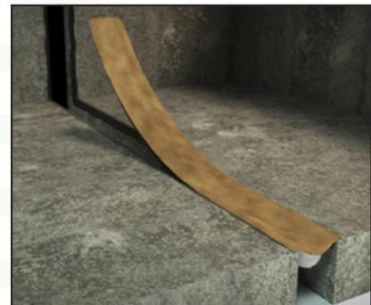
Insérer la nappe dans le joint.
